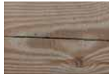
Spannungsrisse durch die Holz-trocknung
