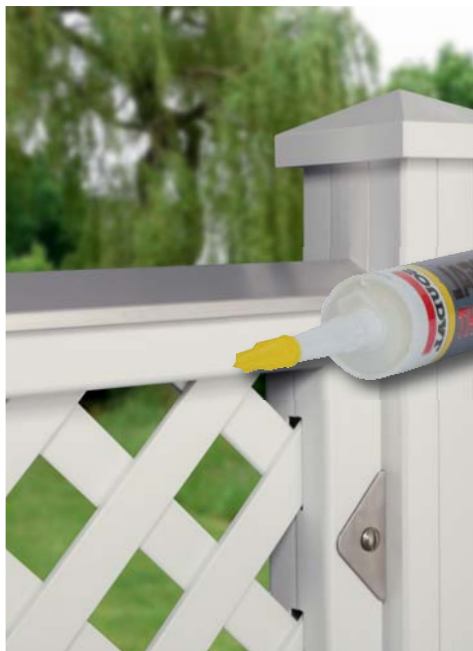
Designaufsatz Alu mit MS-Polymer-Kleber (1398) befestigen.
