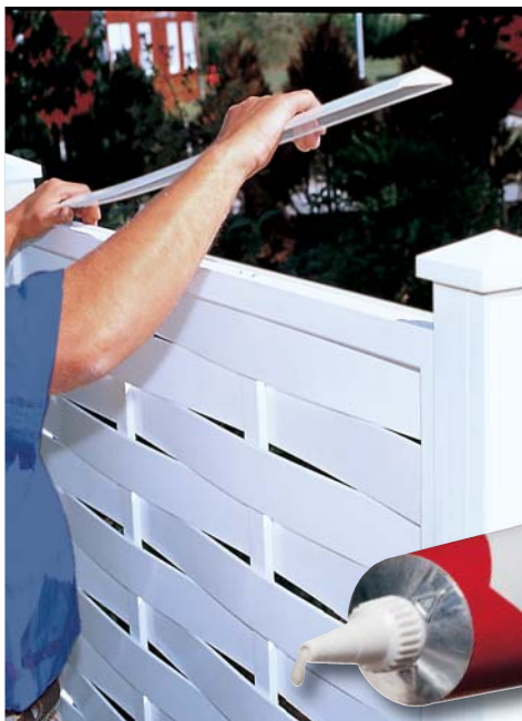
Kleber (0783) zur Befestigung der Aufsatzleisten und der Kunststoffkappen.
