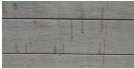
Fleckenbildung durch von Regen angelöste Partikel
