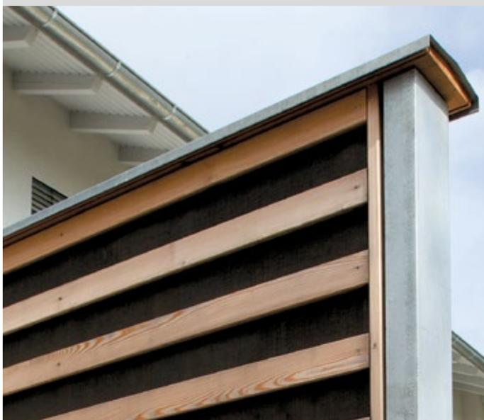
Ausführung mit Stahlpfosten
