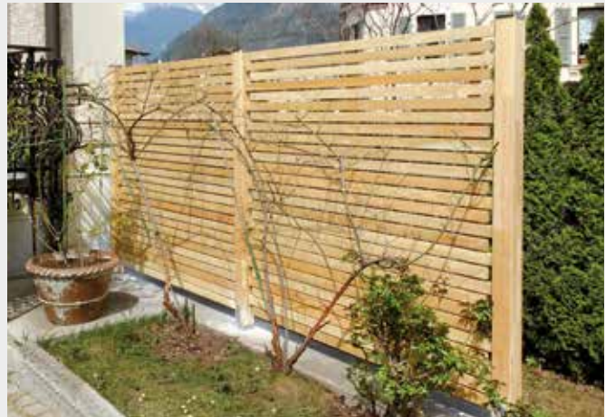
Bei Sonderhöhen horizontal nur Rastermaß von ca. 6,7 cm möglich Beispiel Höhe 179,0 / 172,2 / 165,4 / 158,6 ...
