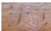
„Pinholes“ bei überseeischen Harthölzern
