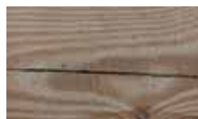
Spannungsrisse durch die Holz Trocknung
